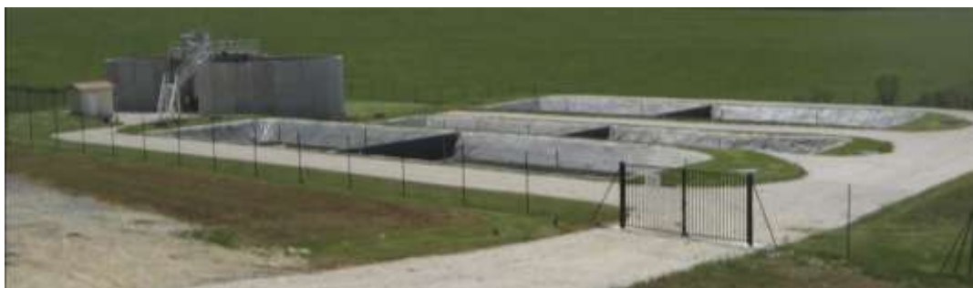
La station d'épuration d'Alvignac lors de sa mise en service en 2009
